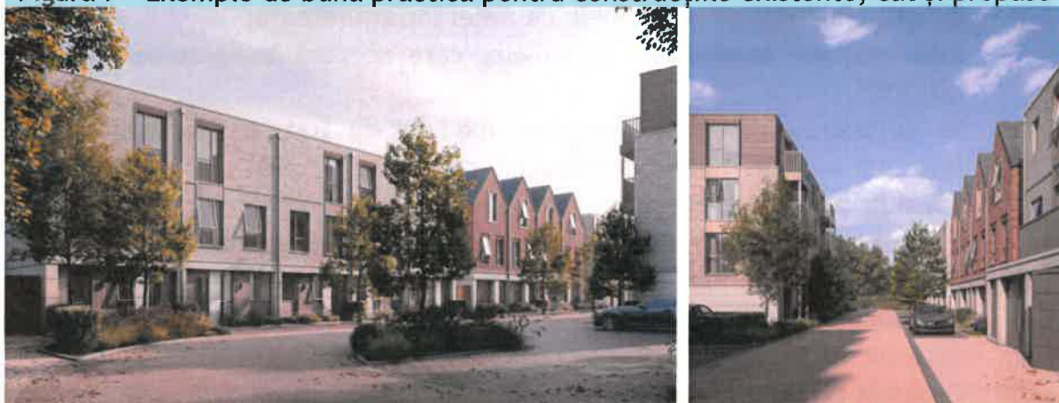
Figura 7 - Exemple de bună practică pentru construcțiile existente, cât și propuse
