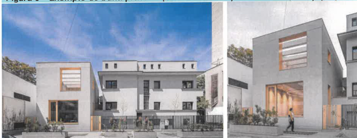
Figura 5 - Exemple de bună practică pentru construcțiile existente, cât și propuse
