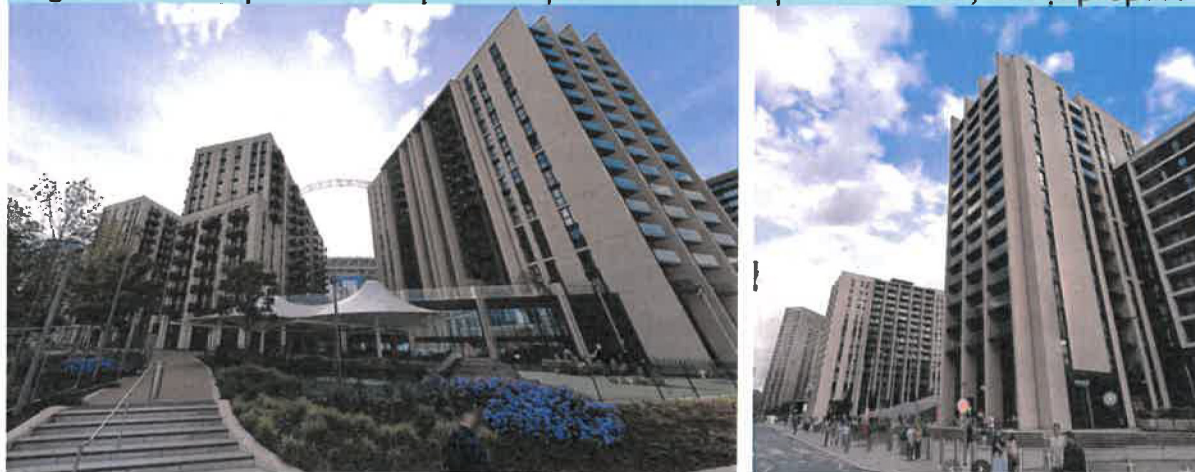
Figura 3 - Exemple de bună practică pentru construcțiile existente, cât și propuse
