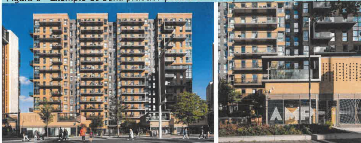
Figura 6 - Exemple de bună practică pentru construcțiile existente, cât și propuse
