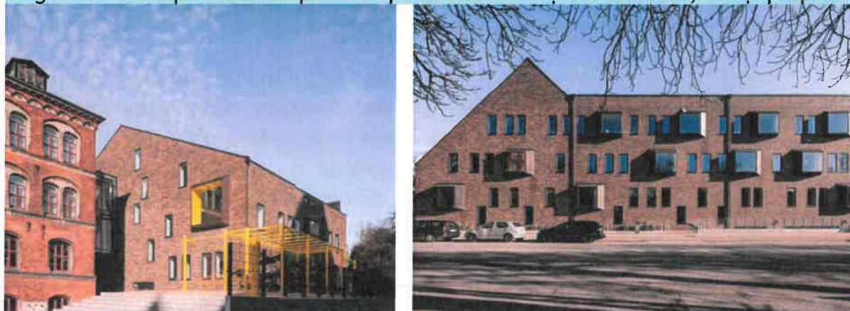
Figura 8 - Exemple de bună practică pentru construcțiile existente, cât și propuse
